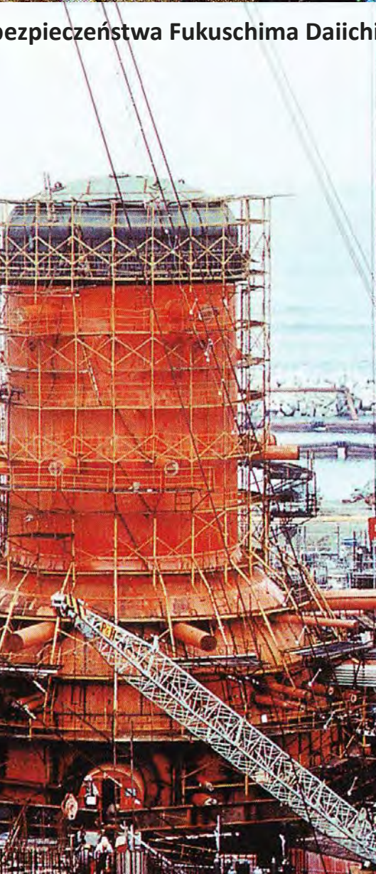
Budowa stalowej obudowy bezpieczeństwa reaktora Fukushima Daiichi Blok 6
