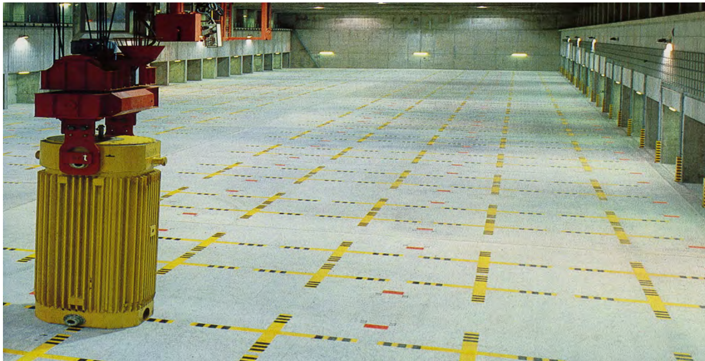
Fot. 2. Wnętrze suchego przechowalnika wypalonego paliwa w Gorleben (Niemcy) z pojemnikiem CASTOR na pierwszym planie. Źródło: H.F.Albrecht i R.Kiedrowski – Kernenergie in Deutschland. Ein Bildatlas/Ullstein.
