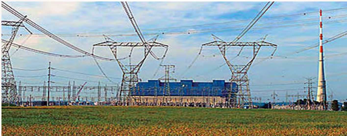
Fot.1 Napowietrzna rozdzielnia i linie wysokich napięć (most energetyczny), łączące amerykańską EJ Browns Ferry 1 z systemem elektroenergetycznym
