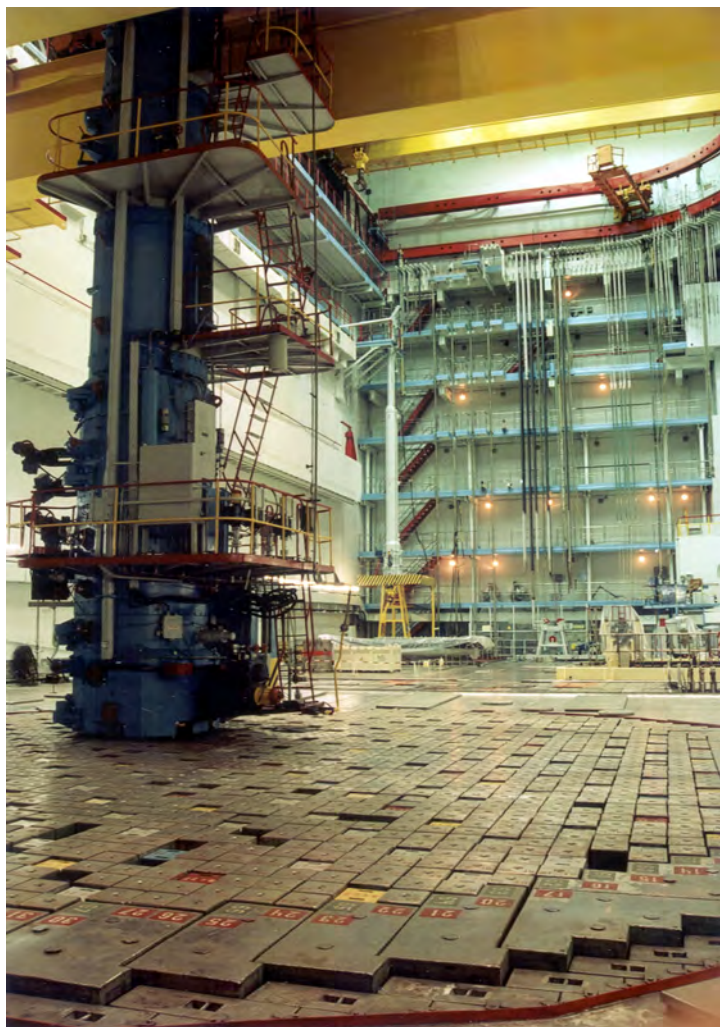
Rys. 10. Hala nad reaktorem RBMK – korki metalowe zakrywające kanały paliwowe zamiast obudowy bezpieczeństwa
