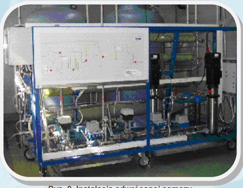
Rys. 9. Instalacja odwróconej osmozy
