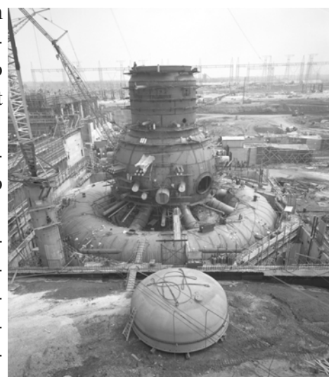
Rys. 12. Reaktor BWR w czasie budowy
