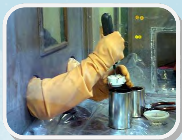
Rys. 6. Demontaż czujki dymu
