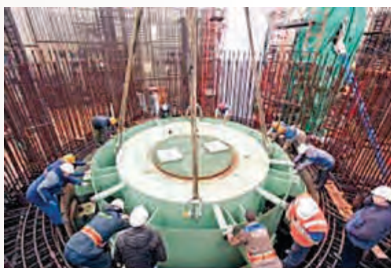
Fot. 13. Z lewej: montaż korpusu; z prawej: załadunek tygla do korpusu 3
