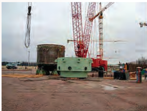
Fot. 12. Z lewej: ustawianie korpusu i tygla na placu budowy; z prawej: dolna część szybu reaktora przygotowana do załadunku korpusu.
