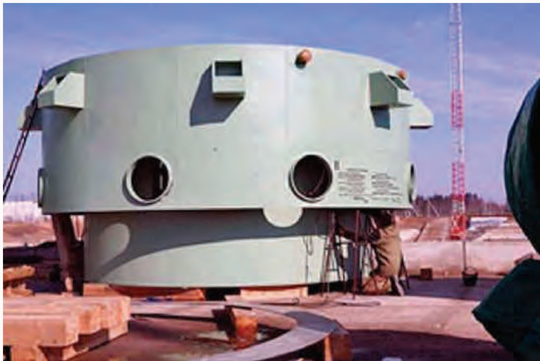
Fot. 11. Korpus tygla (masa 110,5 t, średnica - 6,5 m, wysokość - 5,69 m); prace przygotowawcze przed zamontowaniem w betonowym szybie reaktora. Ogólna masa korpusu i tygla wynosi ok. 800 t
