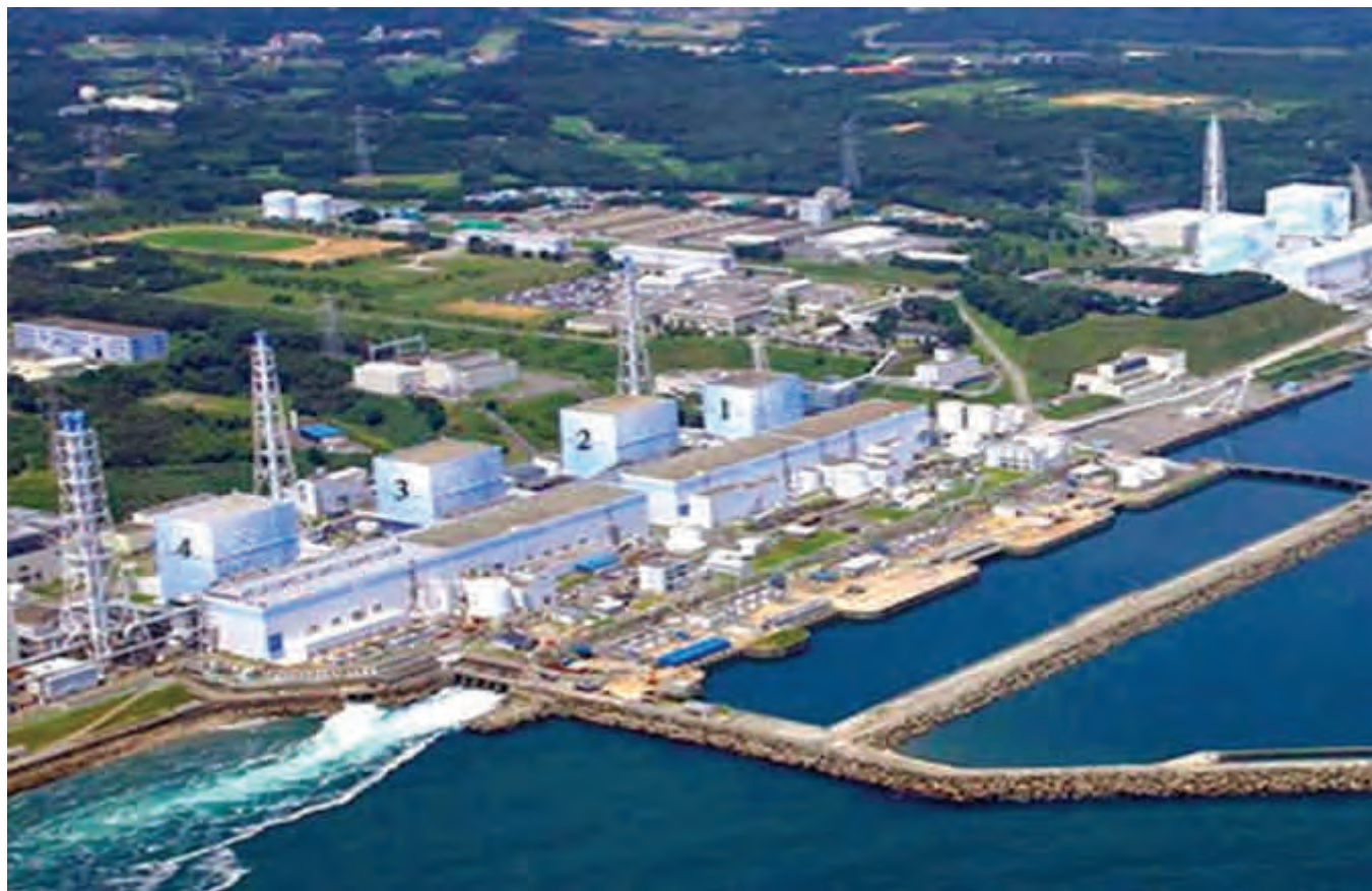
Fot. 6. Widok czterech bloków Elektrowni Fukushima 1 nad brzegiem Oceanu Spokojnego
