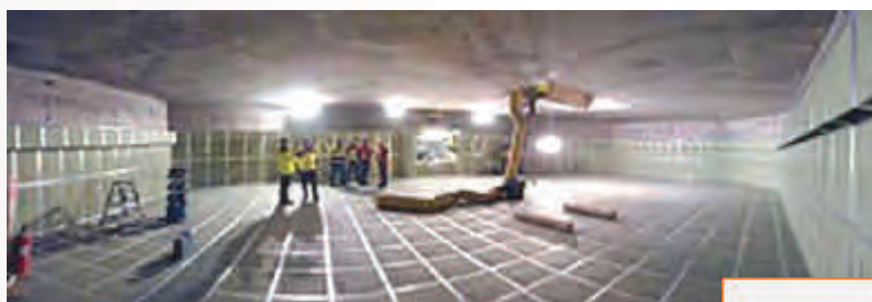
Fot.9. Widok zbiornika retencyjnego 2
