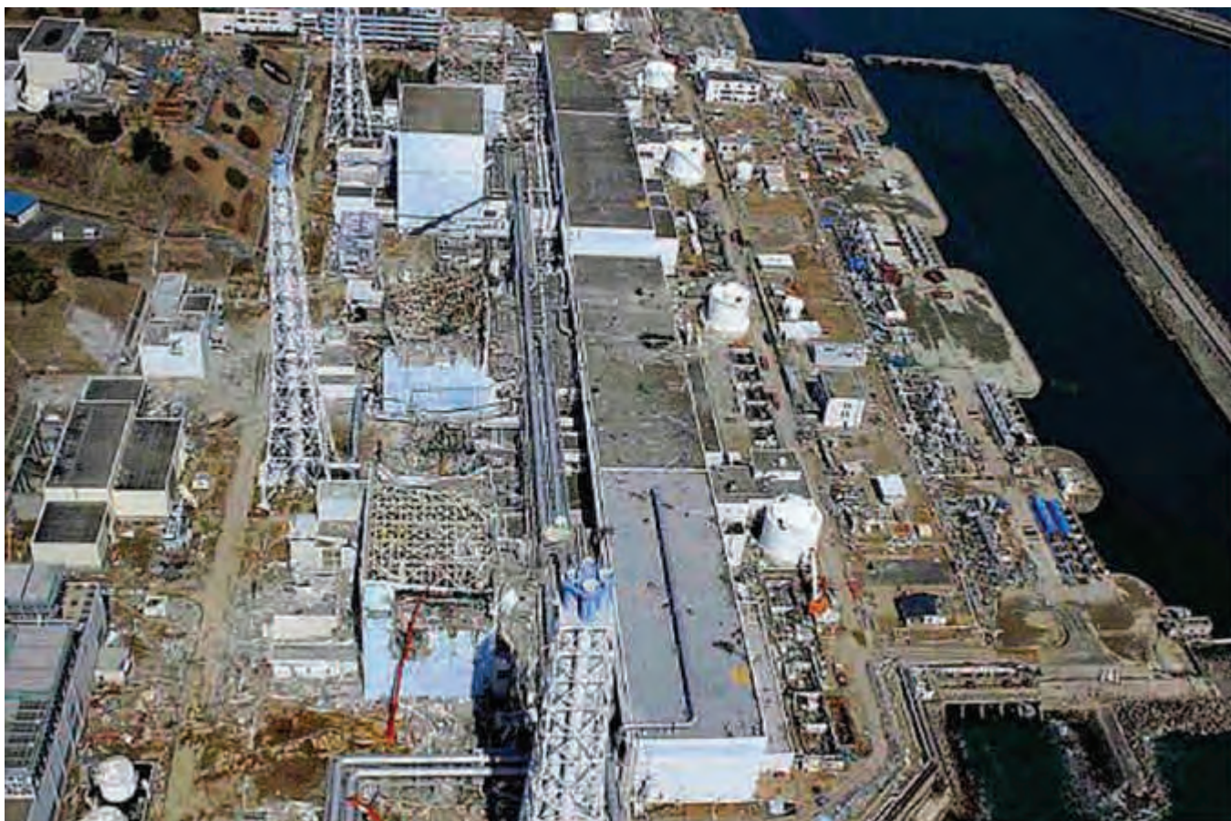
Fot. 7. Zdjęcie lotnicze zrujnowanej Elektrowni Fukushima 1 zrobione 24 marca 2011 r. z bezałogowego samolotu przez Air Photo Service Co. Ltd., Japan
