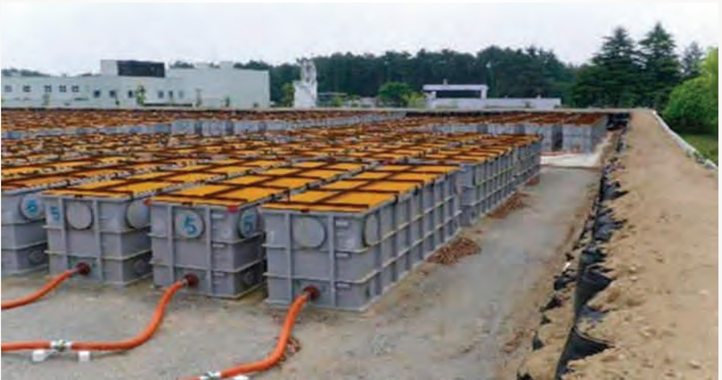
Tymczasowe zbiorniki ścieków radioaktywnych (Fot. Ho/Reuters)
