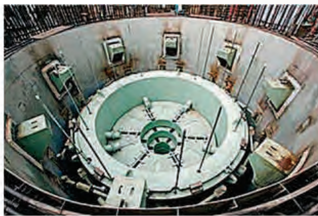
Fot. 12. Z lewej: ustawianie korpusu i tygla na placu budowy; z prawej: dolna część szybu reaktora przygotowana do załadunku korpusu.
