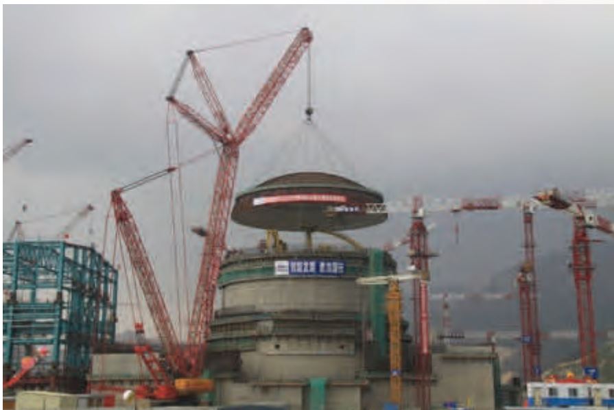
Montaż kopuły reaktora EPR w elektrowni Taishan 1
