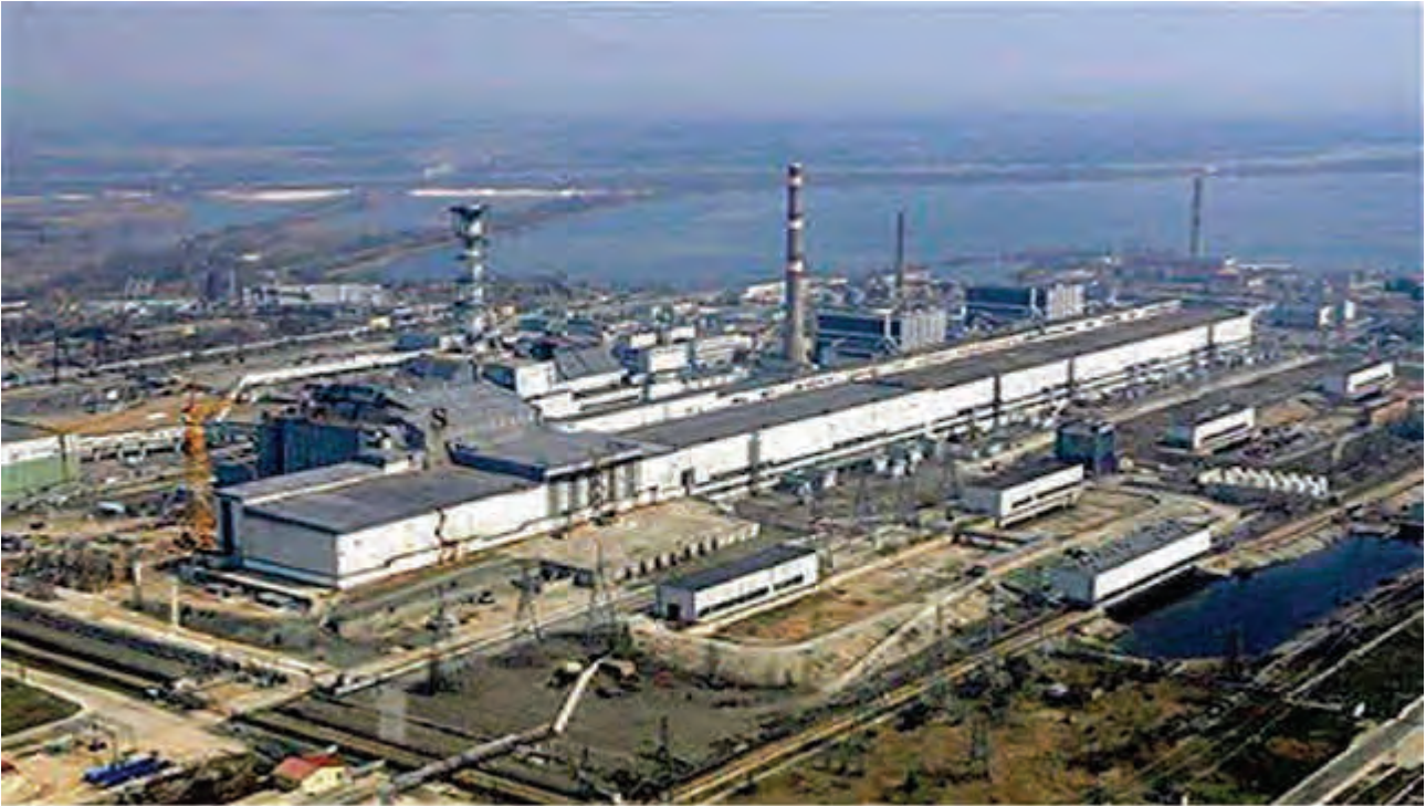
Fot. 4. Widok nieczynnej Elektrowni Czarnobylskiej 1 , S – „Sarkofag”
