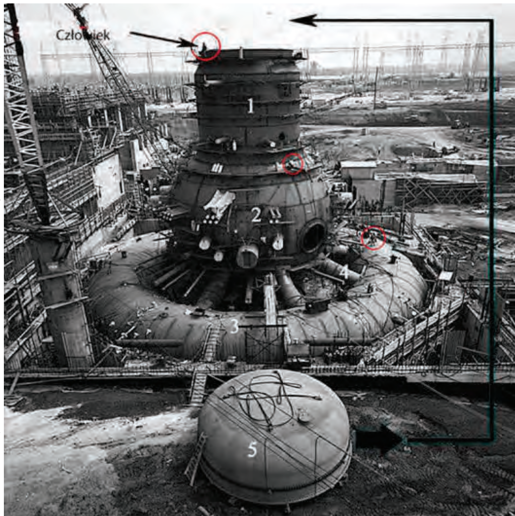
Fot.8. Reaktor EJ Fukushima 1 w budowie 1 : 1 - szybu, 2 - containment (osłona betonowa na rys. 8), 3 - komora dekompresji, tzw. torus (rys. 8), 4 - dukty wentylacyjne (rys. 8), 5 - pokrywa szybu (rys. 8)
