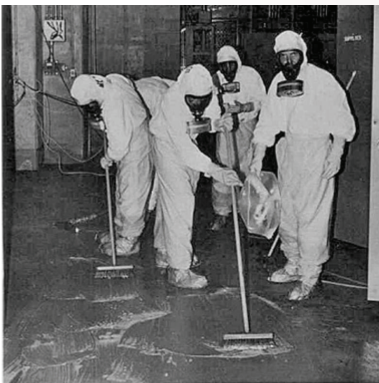
Fot. 3. Dekontaminacja budynku TMI-2 2
