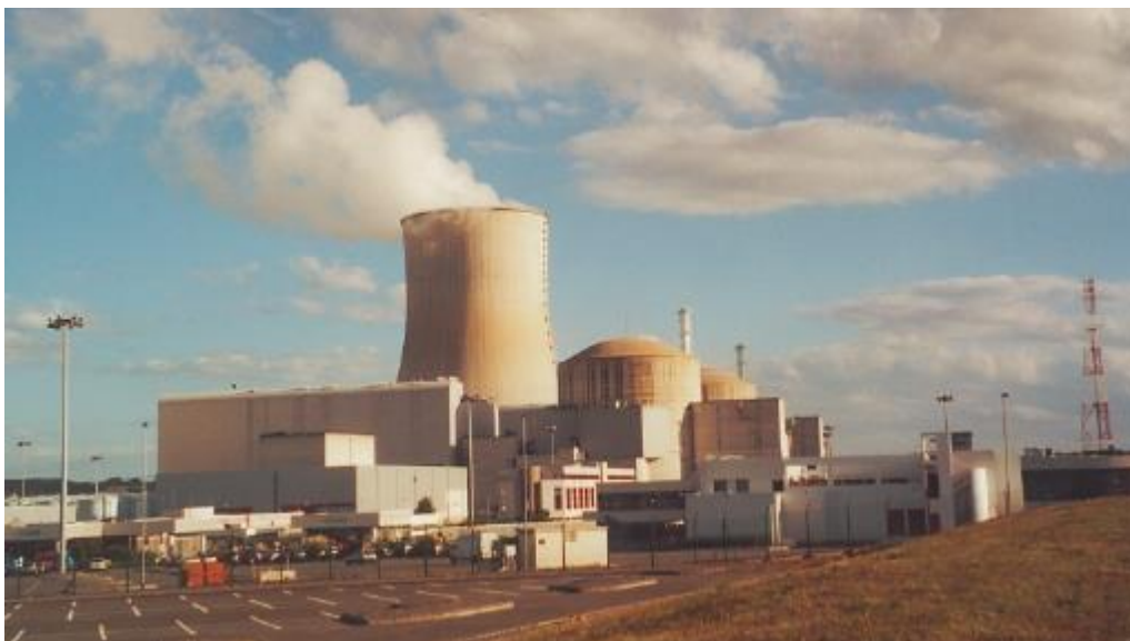
Rysunek 4 Elektrownia Civaux, dwa bloki klasy N4 po 1450 MWe każdy.
