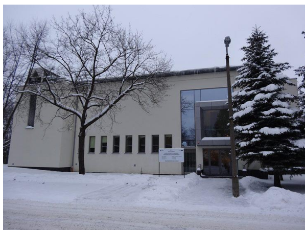
Rysunek 1 Budynek Centrum Informatycznego Świerk. [1]
