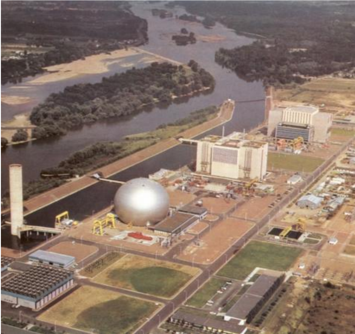
Rysunek 20 Widok na budynki reaktorów EDF-1, EDF-2, EDF-3 w Chinon.
