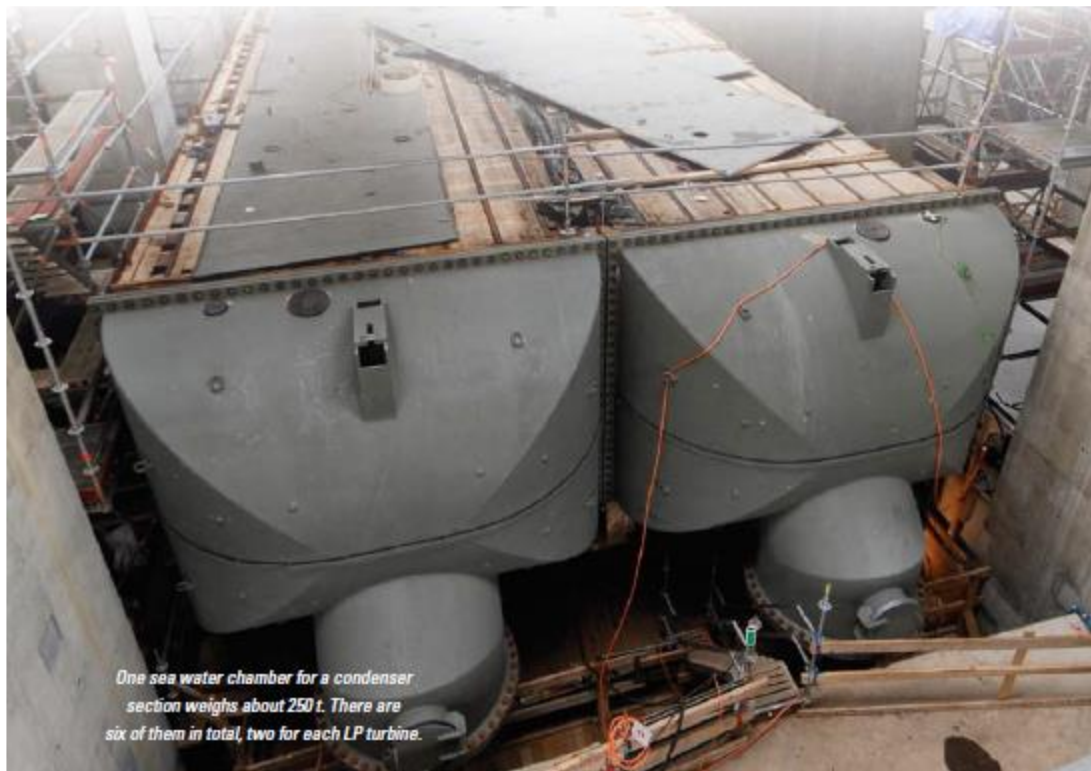
Rys. 14. Skraplacz LP turbiny w elektrowni Olkiluoto 3 [1].
