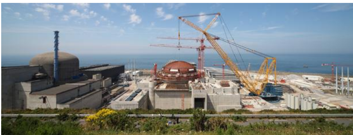
Rysunek 5 Widok na budowę elektrowni Flamanville 3 opartej o reaktor EPR.
