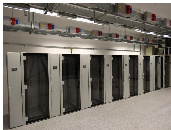
Rysunek 2 Serwerownia przygotowana do montażu sprzętu. [1]
