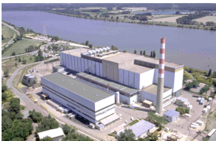
Rysunek 6 Budynek reaktora Fast Breeder Reactor Phenix zbudowanego w Marcoule.
