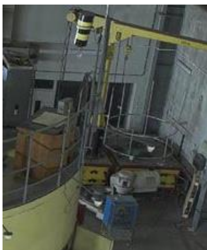
Rysunek 2. Północny narożnik hali reaktora EWA. Pod przesuwną osłoną znajdują się pozostałości po reaktorze MARYLA.
