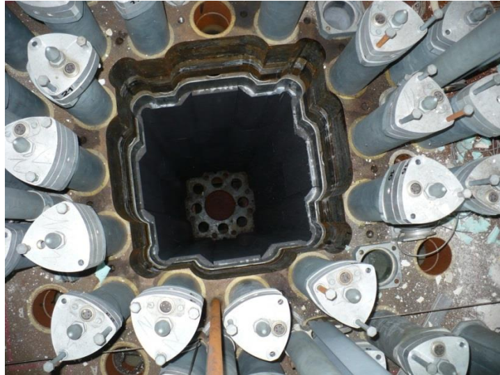
Rysunek 11. Pozostałości po rdzeniu reaktora ANNA.
