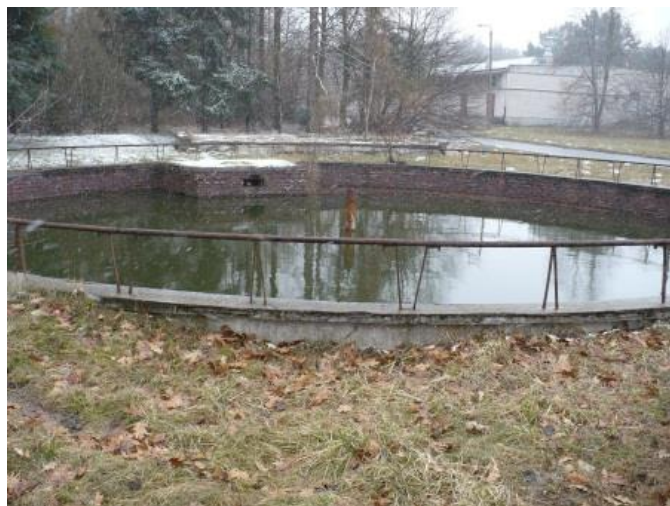
Rysunek 10. . Zewnętrzny element systemu chłodzenia reaktora ANNA.
