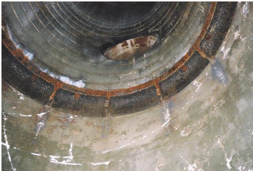
Rysunek 1. Wnętrze pustego korpusu po reaktorze EWA. Widoczny żeliwny pierścień na którym oparty był rdzeń reaktora.
