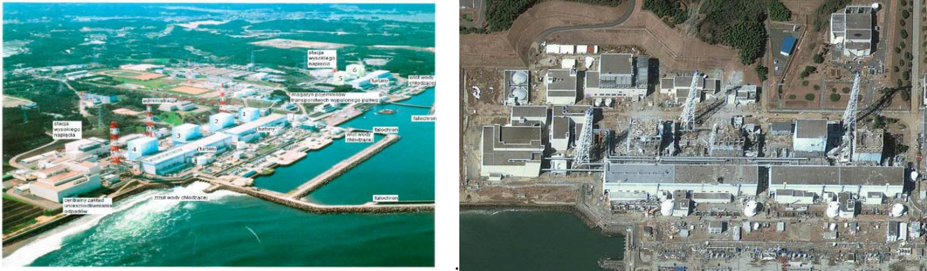
Rys.2 Elektrownia Fukushima Daiichi przed i po awarii
