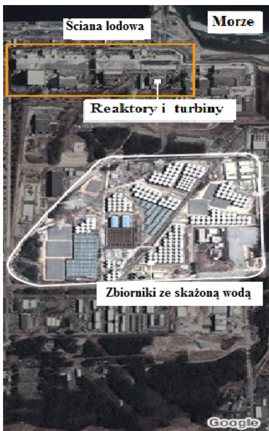
Rys. 23 Rozmieszczenie zbiorników ze skażoną wodą (TEPCO, Reuters)
