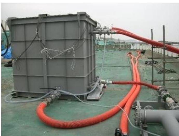
Rys. 25 Zbiornik dekontaminacyjny. Kanał wlotowy
