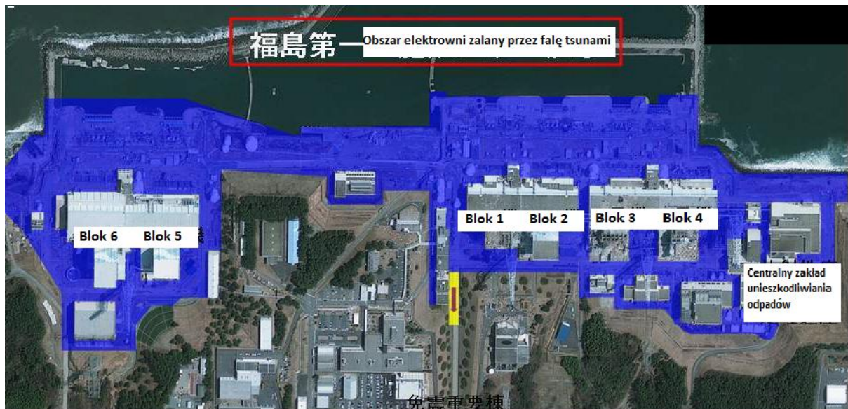
Rys. 13 Obszar elektrowni Fikushima Daiichi zalany falą tsunami (prezentacja Naoki Anahara TEPCO)
