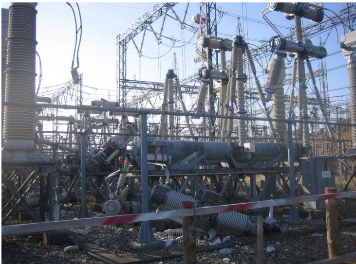
Rys. 12 Zniszczenia sieci elektrycznej (prezentacja Naoki Anahara TEPCO)
