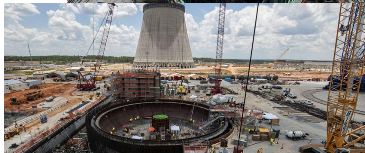
Budowa elektrowni Alvin W. Vogtle Electric Generating Plant w stanie Georgia w USA [Westinghouse Electric]
