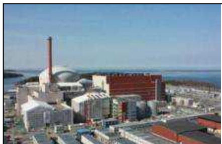
EPR: reaktor wodno-ciśnieniowy, moc brutto: 1750 MWe; EDF/Framatome - Francja
