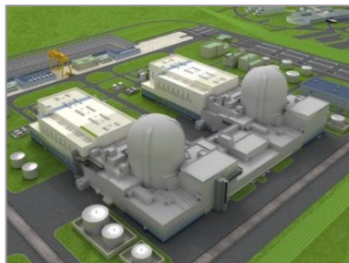
APR1400/EU-APR: reaktor wodno-ciśnieniowy, moc brutto: 1455 MWe; KHNP – Korea
