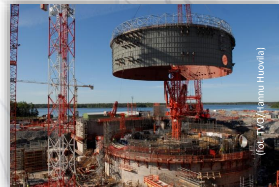
Środkowa i górna część steel linera dla EJ Olkiluoto 3 Finlandia wyprodukowana przez Energomontaż Północ Gdynia
